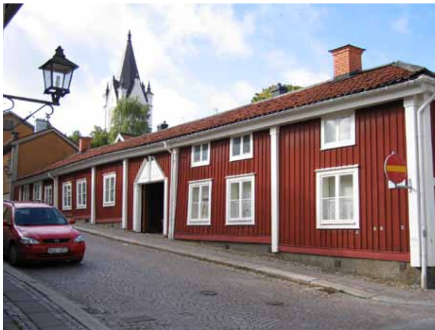
Bergströmska gården. Exteriören är huvudsakligen av 1800-talskaraktär.
