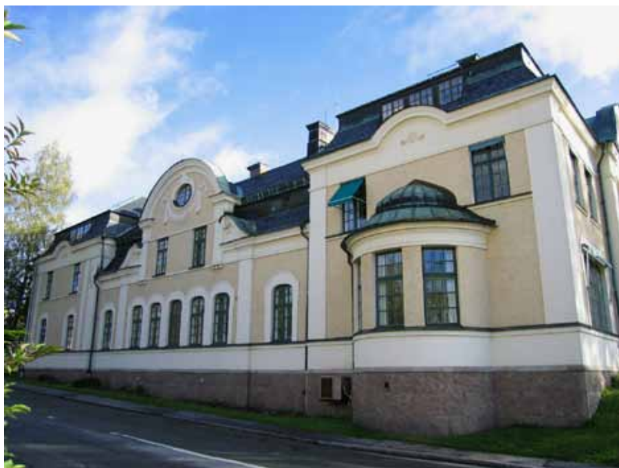
Tingshuset från 1905. En monumentalbyggnad med bevarad jugendkaraktär som minner om det övergripande samhällsansvar som växer fram under andra hälften av 1800-talet
