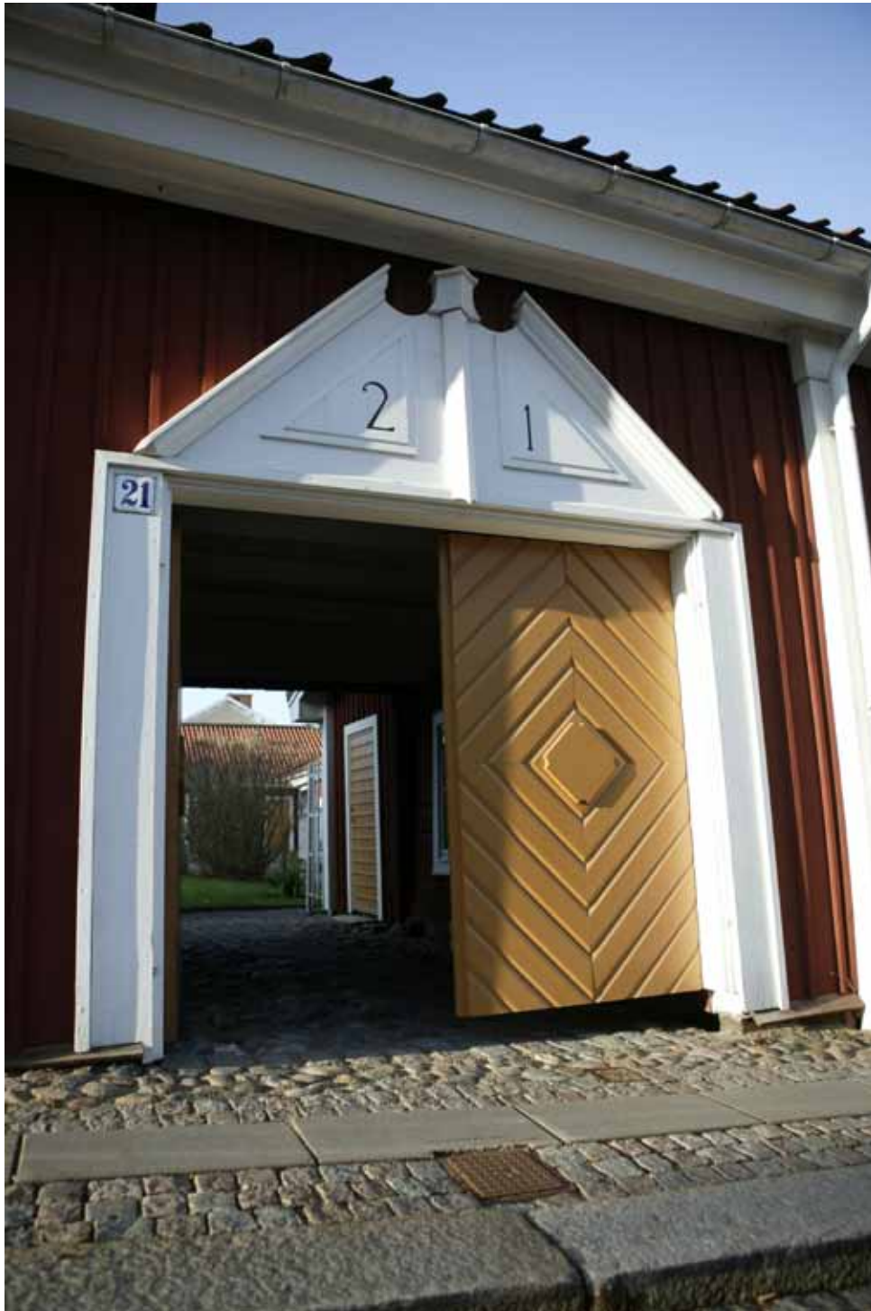
Bergströmska gården. Den kringbyggda gården är typisk för 1700-talets bebyggelsestruktur i Nora. Entren till gården utgjordes av ett portluder. Portarna och portomfattningarna utformades och smyckades med stor omsorg medans fasaderna var förhållandevis enkelt utförda.
